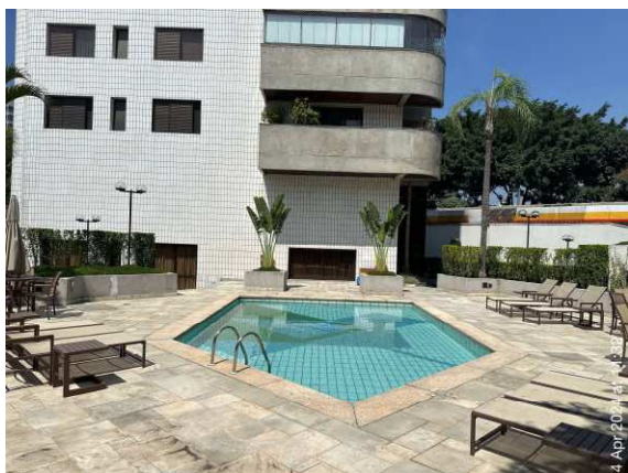
Foto 09 – Vista da área externa do Condomínio Edifício Solar das Gaivotas . Detalhe da piscina.
