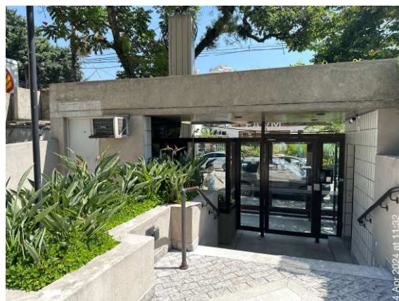
Foto 04 – Detalhe da guarita do Condomínio Edifício Solar das Gaivotas.
