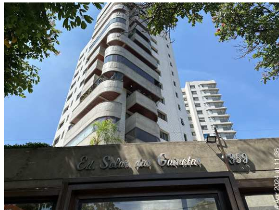
Foto 02 – Detalhe da fachada frontal e lateral do Condomínio Edifício Solar das Gaivotas.
