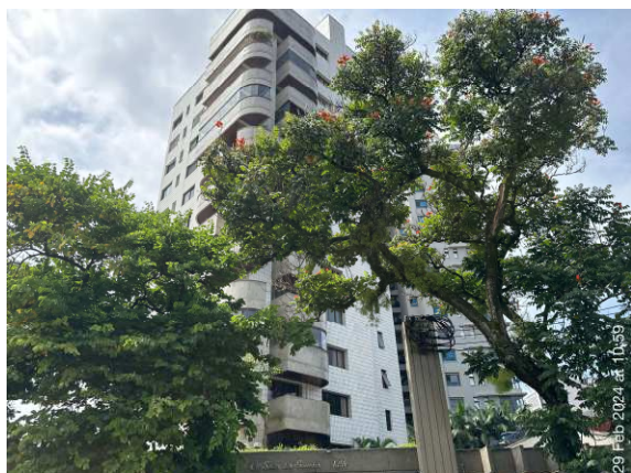
Foto 03 – Detalhe da fachada frontal e lateral do Condomínio Edifício Solar das Gaivotas.
