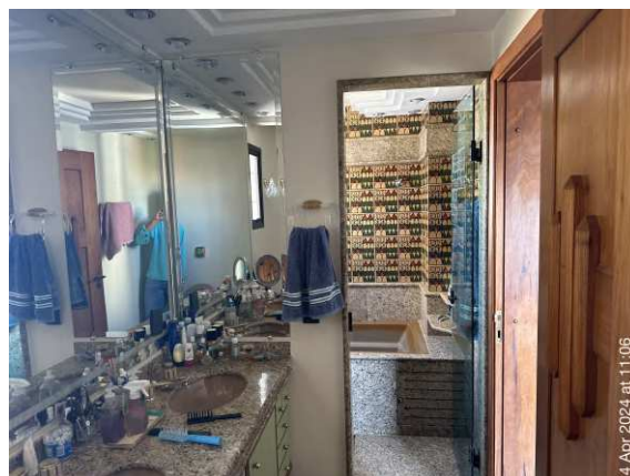
Foto 40 – Vista do sanitário da suíte master do apartamento n.º 121.
